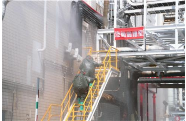
4. 搶救班人員進入液氯儲槽室進行止漏
