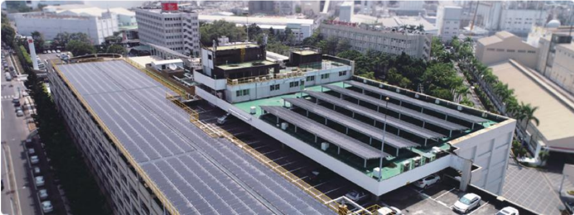
仁武廠太陽能發電系統
